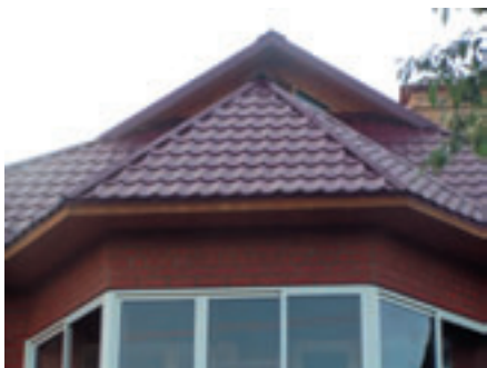
Крыша из металлочерепицы
